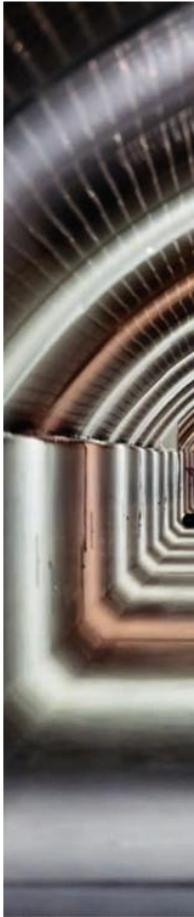
**fig.** Intérieur du bras ouest de 3 km dans lequel circule l'un des deux faisceaux laser de Virgo. Un deuxième bras perpendiculaire à celui-ci permet la propagation d'un second faisceau. Chaque galerie contient un tube à ultra-vide de 120cm de diamètre
