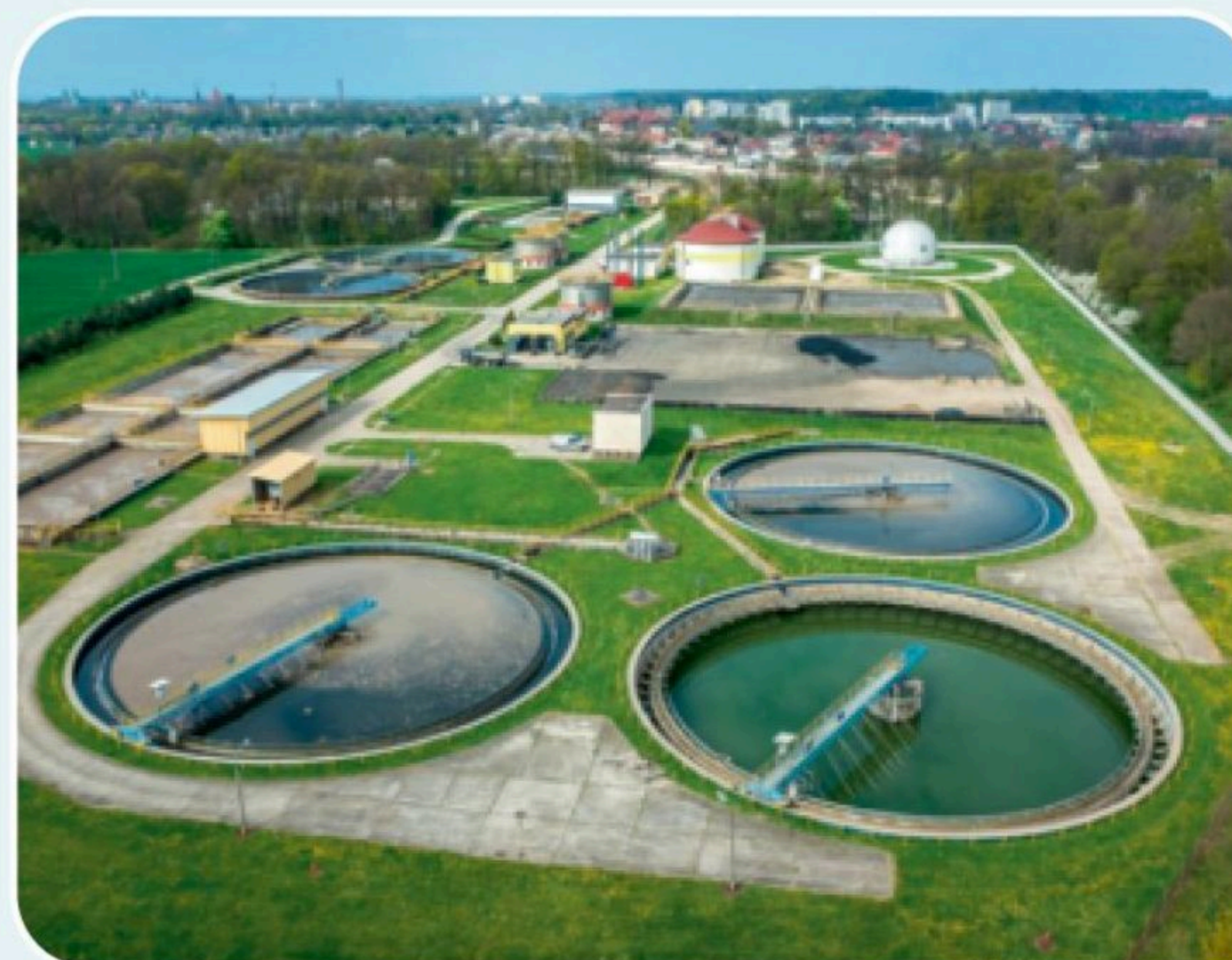
Une station de traitement de l'eau en France
