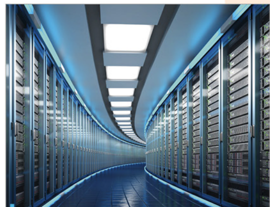
C'est dans les datacenters que sont stockées les données en ligne.
